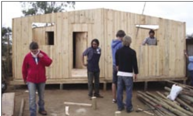
Johanna Baur half beim Aufbau von Holzhäusern
