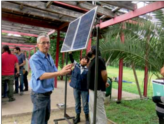
Helmut Schnepf beim Bau der Photovoltaik-Anlage
